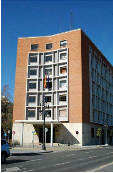
Edificio de Sanidad Municipal. Valencia. Vicente Valls Gadea y Vicente Valls Abad. Demolido. Foto: Fundación Görlich
