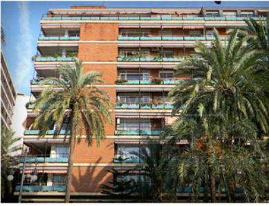
Edificio en Botánico Cavanilles. Valencia. Luis Gutiérrez Soto. Foto: Fundac. Göerlich.
