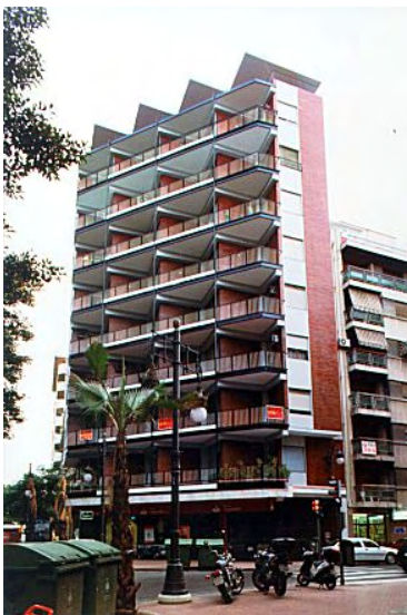
Edificio de viviendas de la Gran Vía Marqués del Turia 29. Valencia. Joaquín G a Sanz. Foto: ConArquitectura
