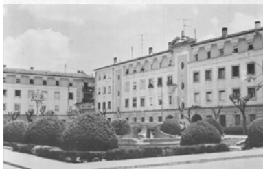
Polígono de Vistabella. Murcia. Imágenes: Cincuenta años de arquitectura en Murcia. La arquitectura, los arquitectos y su organización colegial. 1931/1982
