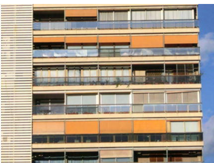
Edificio Plaza Porta de la Mar – El Justicia. Valencia. Fundación Göerlich.
