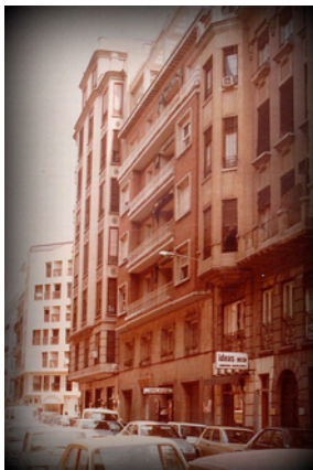
Edificio en Grabador Esteve. Valencia. Vicente Valls Abad. Foto: Archivo V.Valls.
