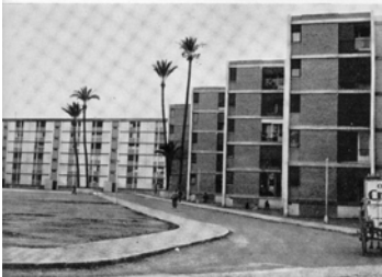
Polígono de la Paz. Murcia. Arquitecto jefe Vicente Valls. Imágenes: Hogar y Arquitectura.
