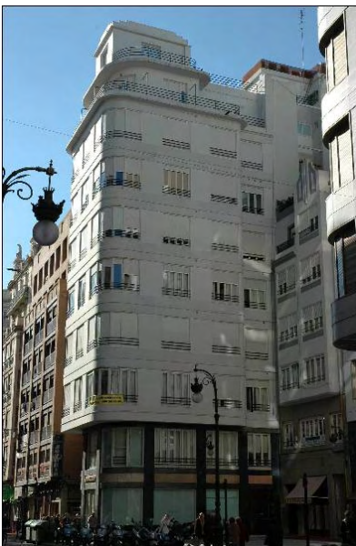
Edificio Roca. Valencia. Foto: Vivienda Moderna en la Comunitat Valenciana.VMCV.
