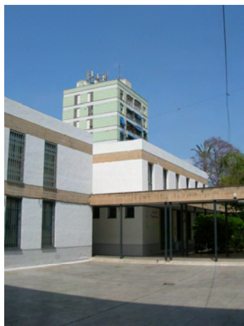
Polígono de la Paz. Segunda fase. Torre y Centro Parroquial. Foto del autor.
